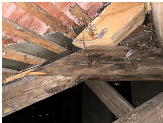
12. kép – fogópár-szarufa közötti kötőelem hiányzik
