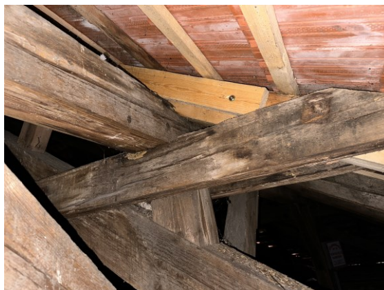
10. kép – fogópár-szarufa közötti kötőelem hiányzik
