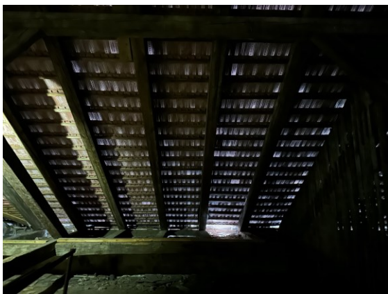
21. kép – hiányos ereszdeszkázat
