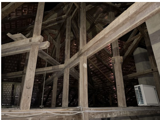
7. kép – kiemelt zárófödém fölötti fedélszék_1
