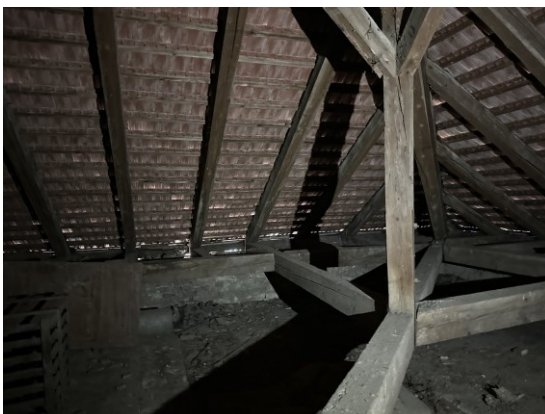
6. kép – kontyolt tetőszakasz
