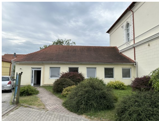
2. kép – keleti mellékszárny udvar felől
