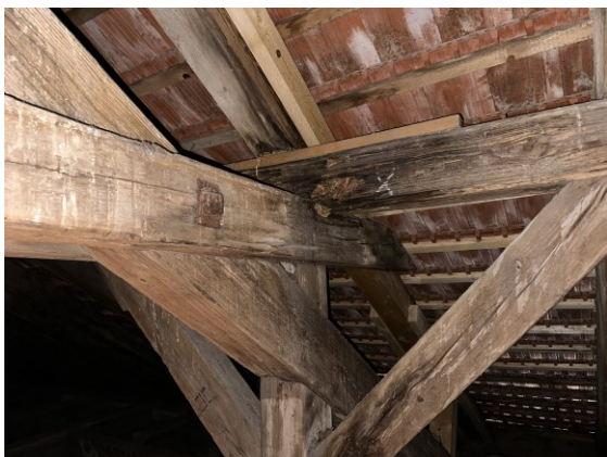
9. kép – korhadt derékszelemen
