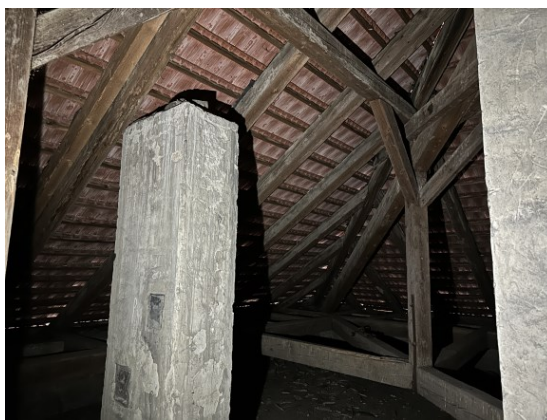
23. kép – tetősík alá visszabontott kémény
