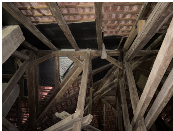
8. kép – kiemelt zárófödém fölötti fedélszék_2
