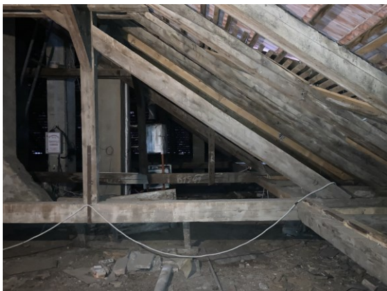
4. kép – háromállószerűs fedélszék
