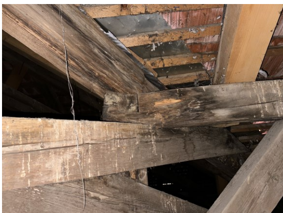
13. kép – korhadt derékszelemen
